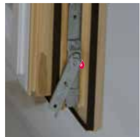
Flügelheber mit Schaltsperr e in Drehrichtung, hebt automatisch beim Kippen und Schließen den Flügel an, generelle Entlastung des Flügels
