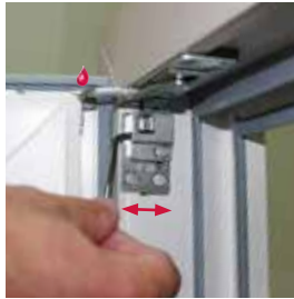
Flügelandruckeinstellung am Band oben + / - 1 mm (Abb. 1)
