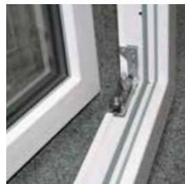
5. Flügel in Kippstellung neigen, anheben und aushängen
