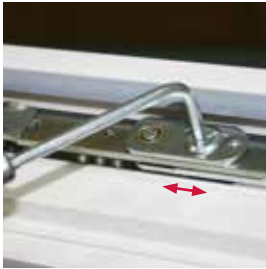
Seitenverstellung oben - 1 / + 2,5 mm (Abb. 1)
