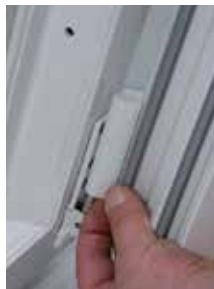
Höhenverstellung Beschlagsabdeckung entfernen
