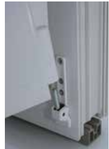
7. Flügel aus Ecklager unten heraus ziehen
