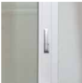
2. Griff in Kippstellung bringen, Flügelheber muss auslösen
