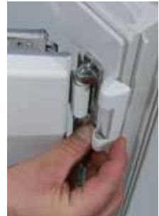
3. Beschlagsabdeckung oben entfernen
