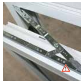
3. Fenster kippen, Scherenarm einhängen und Verriegelungshebel schließen. Achtung: Arretierfeder muss hörbar einrasten!
