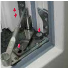
Höheneinstellung am Band unten + 2 / - 1 mm (Abb. 2)
