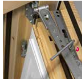
Flügelandruckeinstellung an der Schere oben + / - 1 mm
