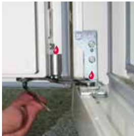
Flügelandruckeinstellung am Band unten + / - 0,7 mm (Abb. 2)
