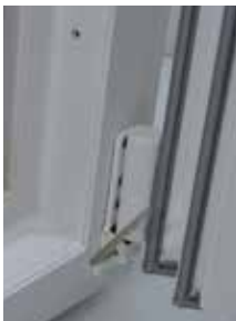
Seitenverstellung unten + / - 2 mm
