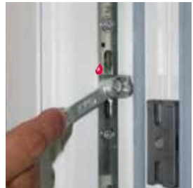
Sicherheitspilzzapfen, Flügelandruckeinstellung (SW 11) + / - 1 mm
