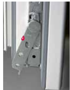
Flügelheber mit Schaltsperre in Dreh- richtung, hebt automa- tisch beim Kippen und Schließen den Flügel an, Entlastung des Flügels
