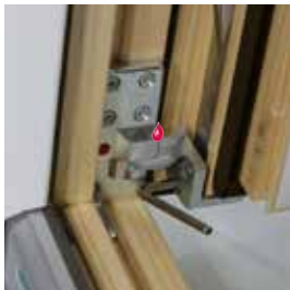
Seitenverstellung unten + / - 2 mm
