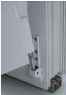
1. Flügel im unteren Ecklager einführen
